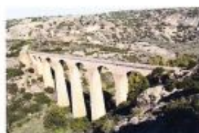
Viaducto, Via Ojos Negros
