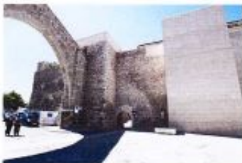
Acueducto los Arcos, Torre del Agua y Portal de S. Miguel
